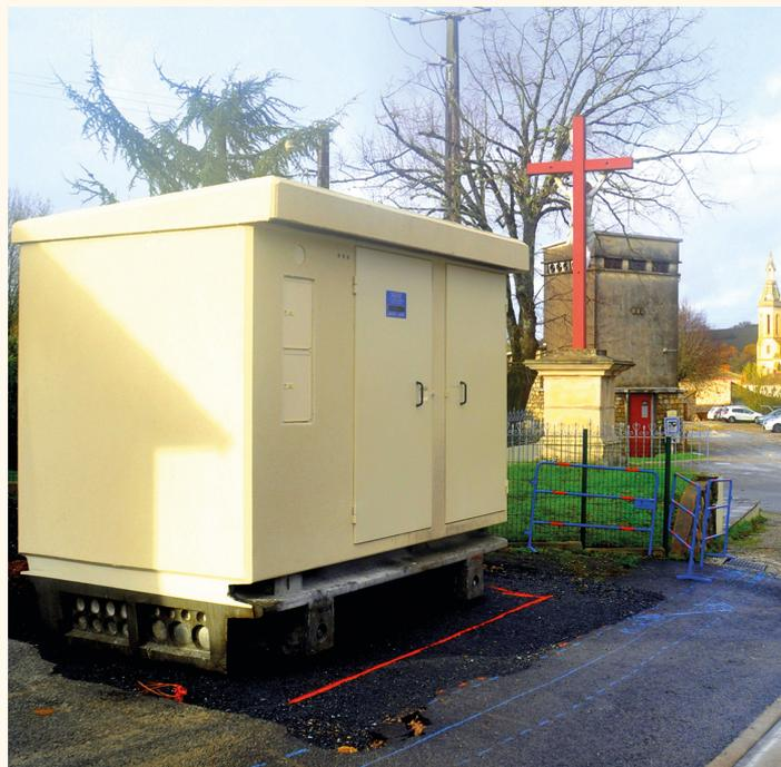
Le transformateur béton du Mercadial au second plan sera détruit pour sa partie haute en béton et remplacé par celui-ci au 1er plan.
